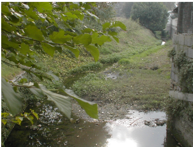
Il Cavo Biocco incrocia il Vaso Fontanelle (zona esondabile) in loc. Caselle.
