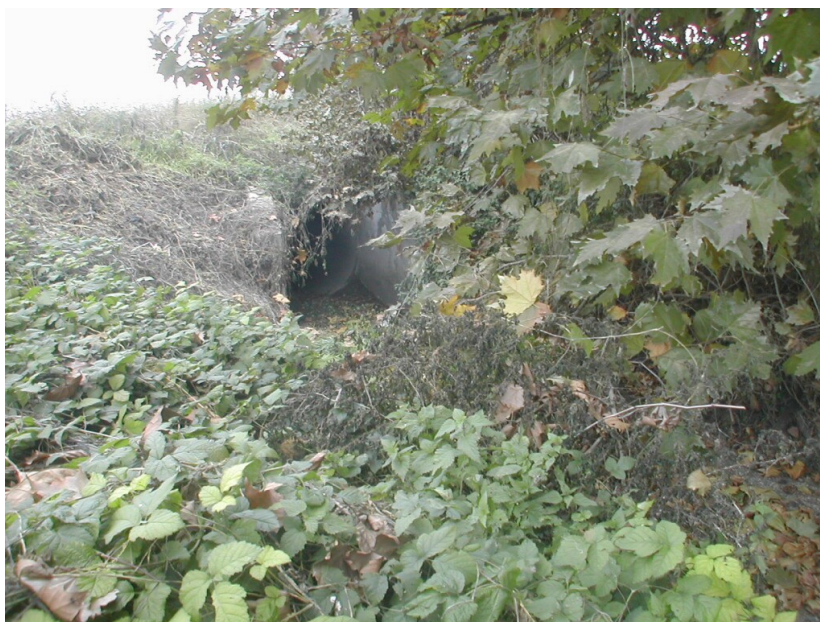
Il Cavo Biocco, intubato nella zona artigianale e dopo aver attraversato la strada per Borgosatollo, torna a cielo aperto prima di incrociare il Vaso Fontanelle.
