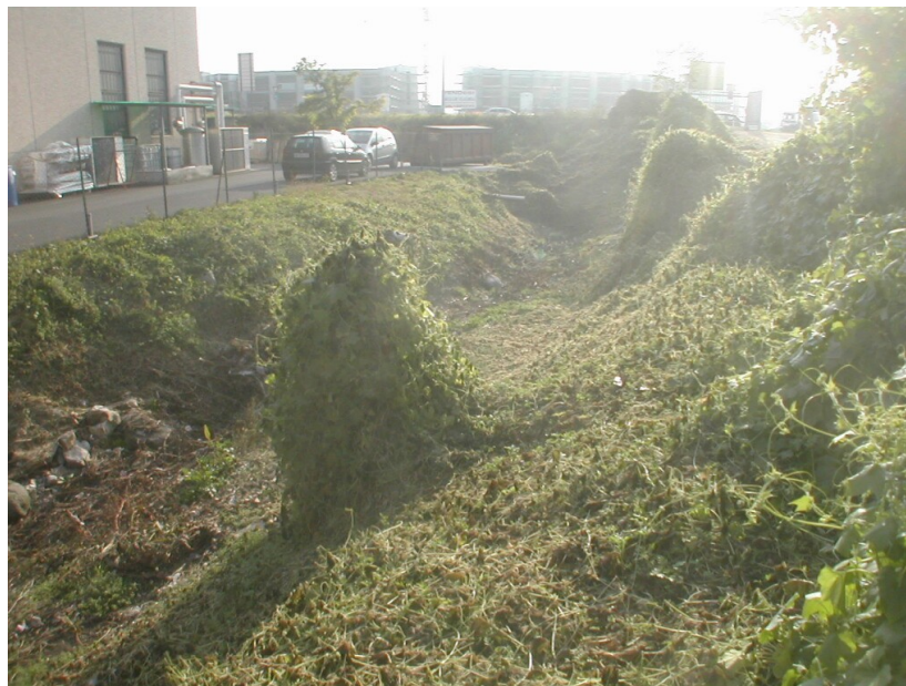
Il Colatore Biocco nella zona artigianale al confine con il comune di Brescia.
